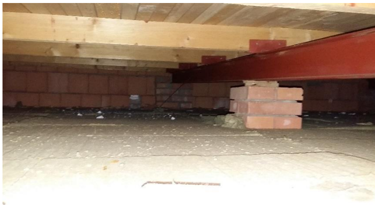
Foto č. 7 - Sonda do střešního pláště, pohled do vzduchové dutiny střechy
