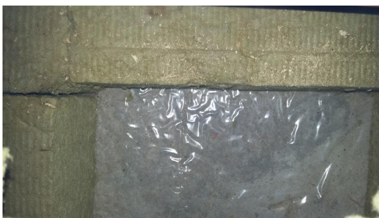
Foto č. 8 - Sonda do střešního pláště - vrstvy na stropní konstrukci
