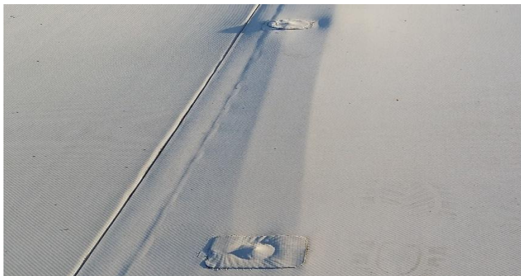
Foto č. 4 - Poškození stávající hydroizolace hlavami kotevních prvků, patrné nedostatečné kotvení stávající hydroizolace
