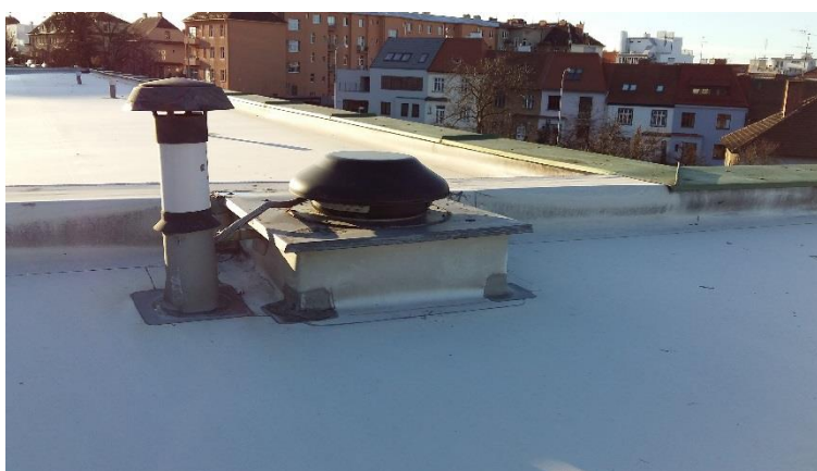
Foto č. 5 - Detail ventilátoru a odvětrání kanalizace
