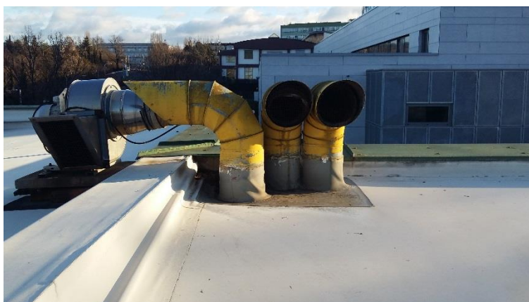
Foto č. 6 - Pohled na skupinu výdechů VZT - problematický detail, který může být jedním ze zdrojů zatékání
